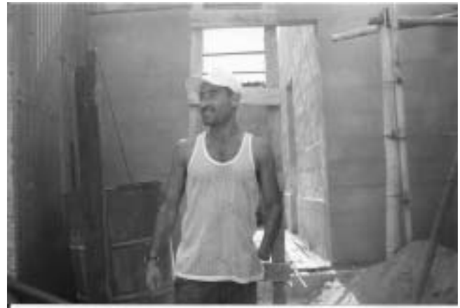
Bild 4: Auf der Baustelle
