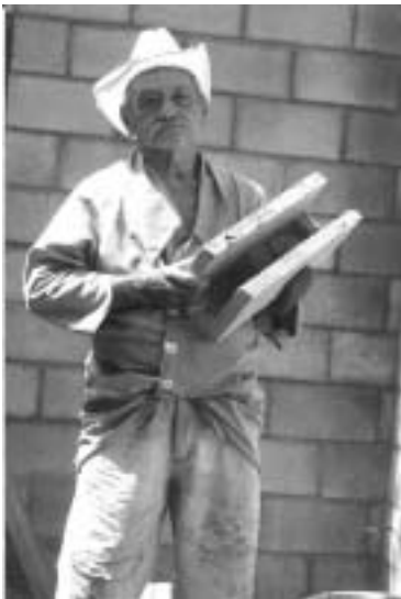
Bild 3: Mitarbeit am Hausbau
